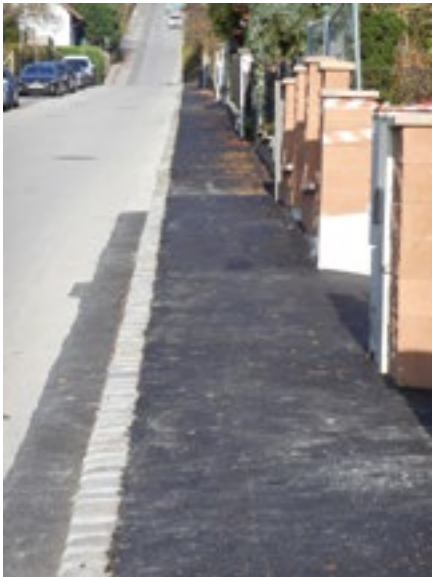
Gehsteig in der Ferdinand Ramler-Straße: Nahtlose Gehsteigsanierung
