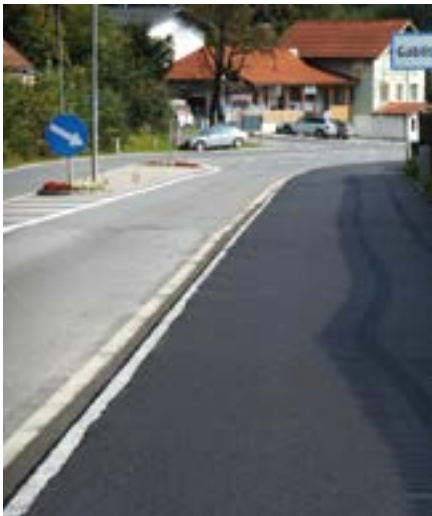
Neuer kombinierter Rad- und Fußweg zum Sportplatz als gefördertes Pilotprojekt zum RadlGrundnetz
