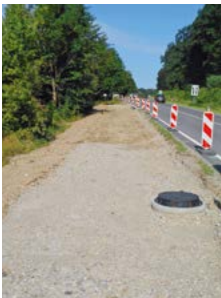
Nach den technischen Einbauten folgt die Asphalttschicht für den Radweg zum Sportplatz
