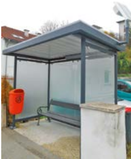
Moderne Buswartehäuschen in Gablitz
