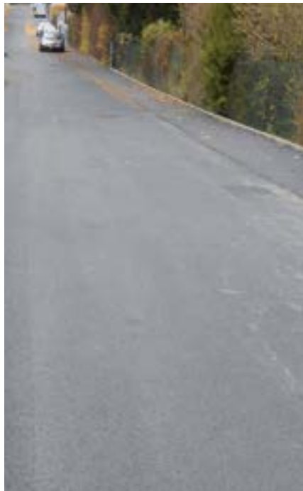
Komplett erneuerte Paracelsusgasse
