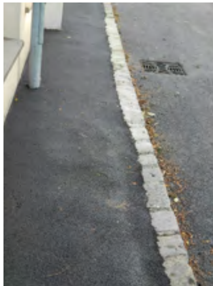
330 m Gehsteiglänge mit Einlaufschächten wurden ebenfalls komplett erneuert
