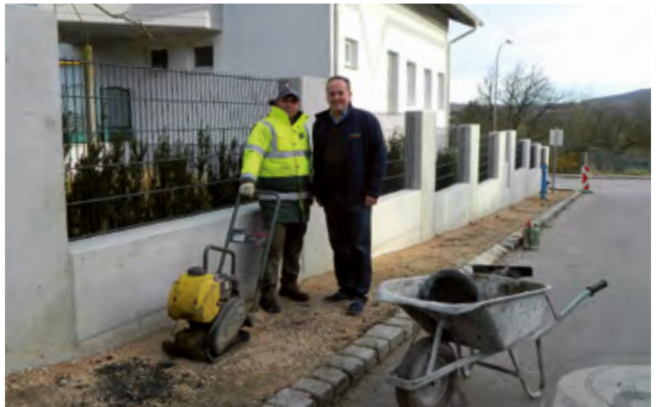
Von kleineren Sanierungen bis hin zum Straßenbau - Preislich abgedeckt mit der Kontrahentenvereinbarung
