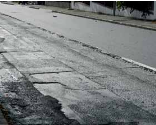
Im Vordergrund die desolote Straße vor der Sanierung, dahinter die bereits neu aufgetragene Deckschicht
