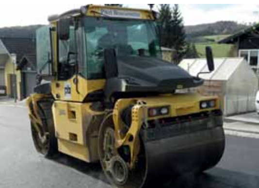
Endverdichten des aufgetragenen Belages mit Straßenwalze, die über wassergekühlte Walzenräder verfügt
