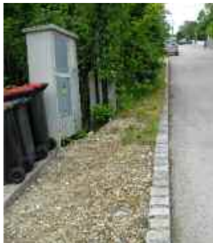
In der Hamerlinggasse wird nun der Gehsteig begehbar gemacht
