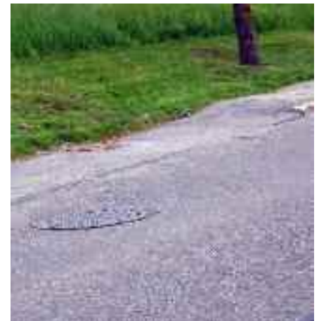
Das langjährige „Provisorium“ in de Hauersteigstraße wird saniert
