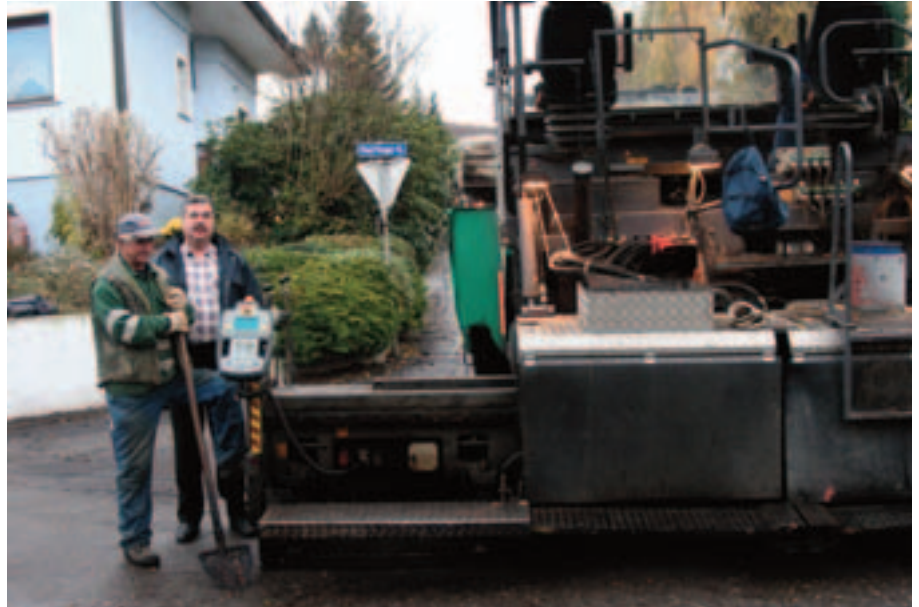
GGR Wolfgang Rott informiert sich über die Fortschritte bei den Belagsarbeiten
