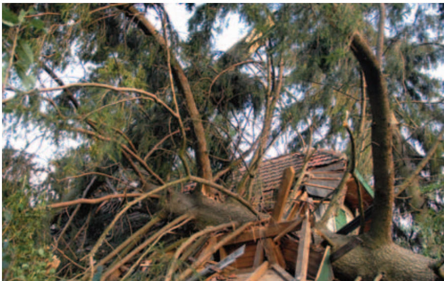
Eines der schwer beschädigten Wohnhäuser in der Kirchengasse
